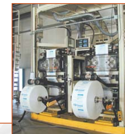
Plataforma desplazable bajo silos Moveable platform under silos battery
